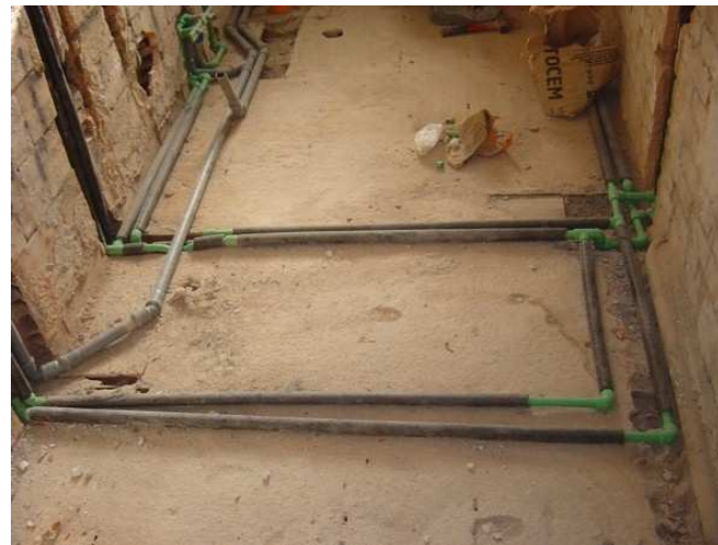
TUBAZIONI MULTISTRATO TERMOSALDATE E COIBENTATE
